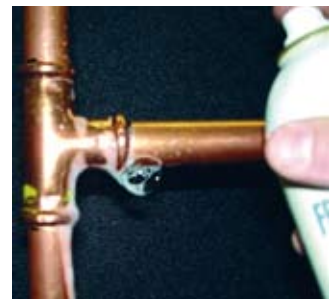
Um ungeprüfte Verbindungen zu kontrollieren, können schaumbildende Mittel oder ...
