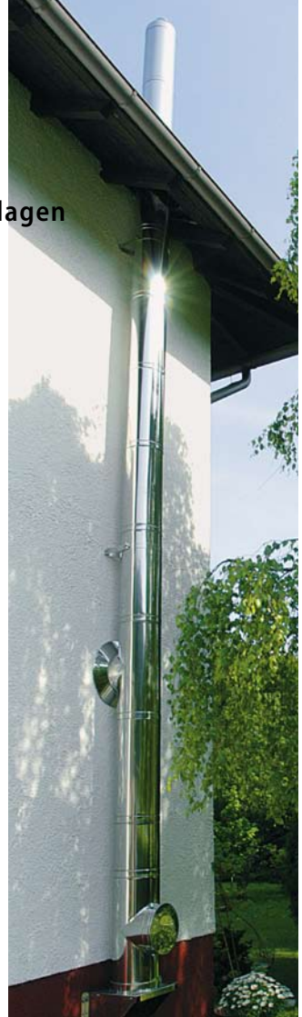
Werden Abgasanlagen errichtet, muss entschieden werden, wo die Reinigungsöffnungen anzuordnen sind
