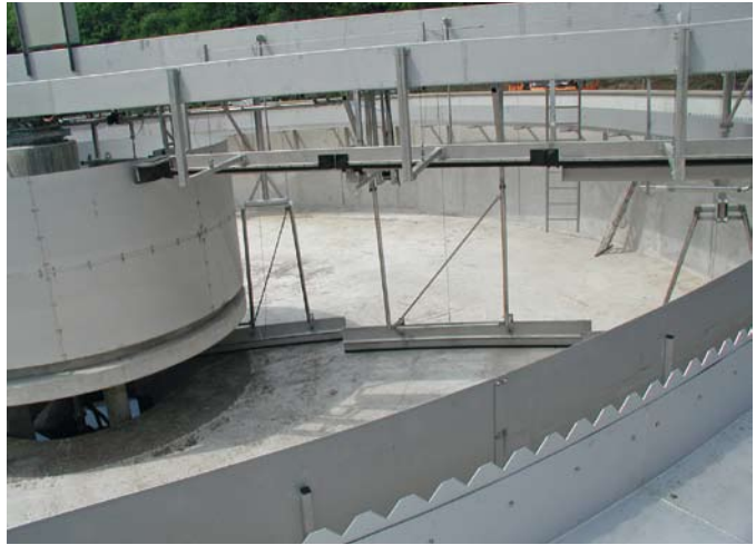
Nagelneu, noch leer und deshalb alles gut zu erkennen: Ein Nachklärbecken für die chemische Reinigungsstufe
