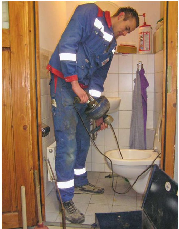
Abflussverstopfungen wird mit modernen Maschinen zu Leibe gerückt, an die persönlichen Schutzmaßnahmen wird aber oft nicht gedacht
