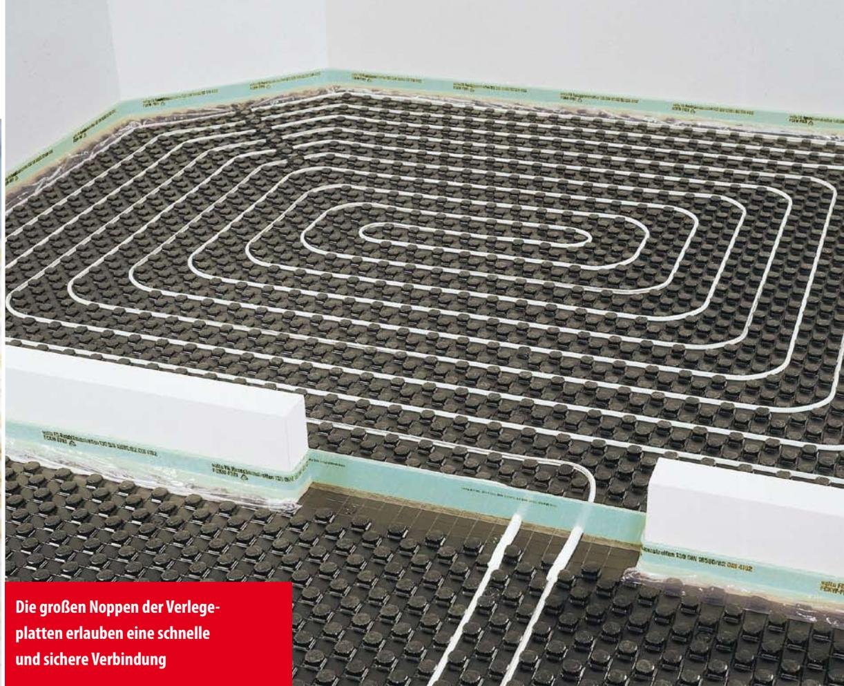
Die großen Noppen der Verlegeplatten erlauben eine schnelle und sichere Verbindung
