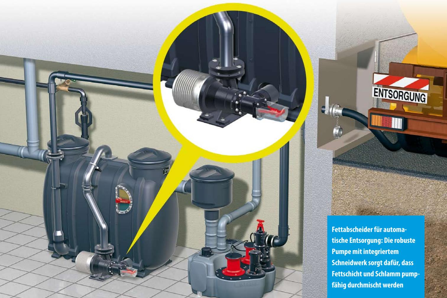
Fettabscheider für automatische Entsorgung: Die robuste Pumpe mit integriertem Schneidwerk sorgt dafür, dass Fettschicht und Schlamm pumpfähig durchmischt werden
