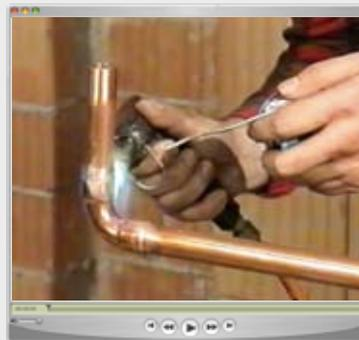
Wie man die verschiedenen Rohrverbindungen richtig herstellt, kann man sich im Internet mit dem Film „Rohrverbindungen“ ansehen:
