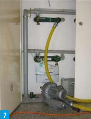
[7] Ist die überschüssige Dispersion aus der Leitung herausgemolcht, sorgt ein Luftgebläse für die Trocknung
