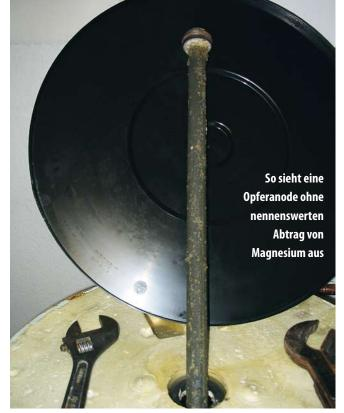
ohne Abnutzung der Anode im Keller stehen, während zwei Häuser weiter ein Speicher gleichen Typs bereits weggegammelt ist. Weiterhin ist noch entscheidend, wie häufig das Wasser des Speichers getauscht wurde, also wie viel Warmwasser entnommen wurde. Das Nutzerverhalten trägt also ebenso zur Belastung der Anode bei. Wir empfehlen daher dringend die Sichtkontrolle der Anode bei jeder Wartung. Das Opfern von vielleicht fünf Minuten ist aus unserer Sicht gut angelegt. EH
