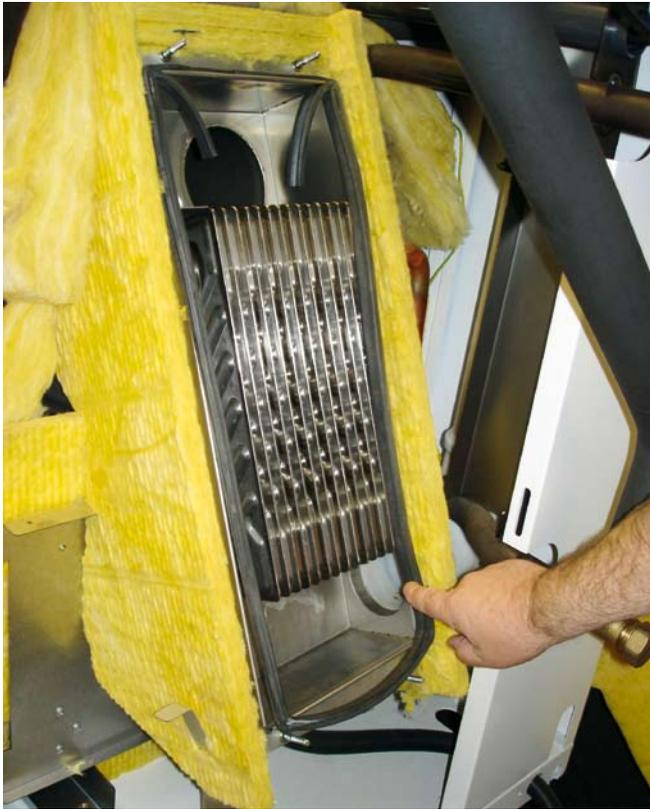
**Dieser zweite Wärmetauscher eines Öl-Brennwertkessels entzieht den Verbrennungsgasen zusätzlich Wärme, während sie ihn von oben nach unten durchströmen; die Hand zeigt den Abgasauslass**
