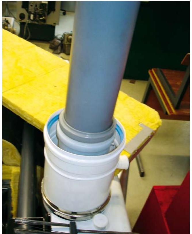
**Die Verbrennungsluft wird über den Ringspalt an der Abgasabführung angesaugt – somit ist auch ein raumluftunabhängiger Betrieb möglich**
