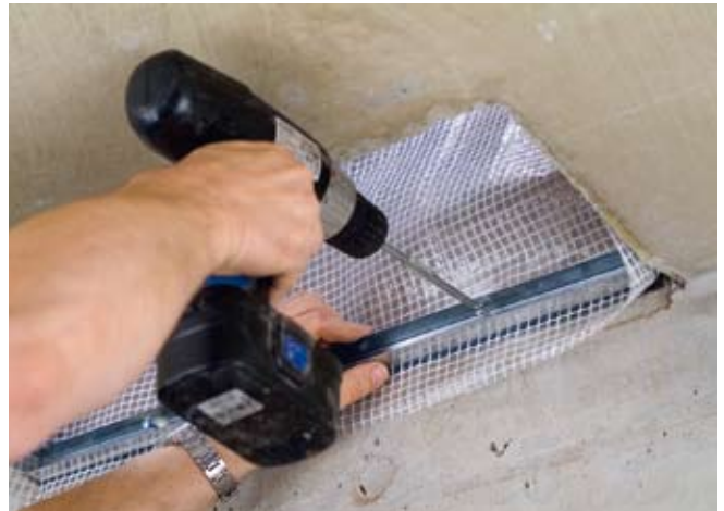
... und die Schienen und die Spezialfolie montiert
