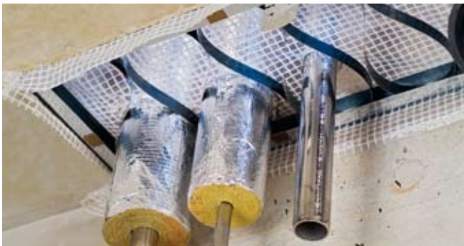
Die Rohre mit oder ohne Dämmung werden durchgeführt ...
