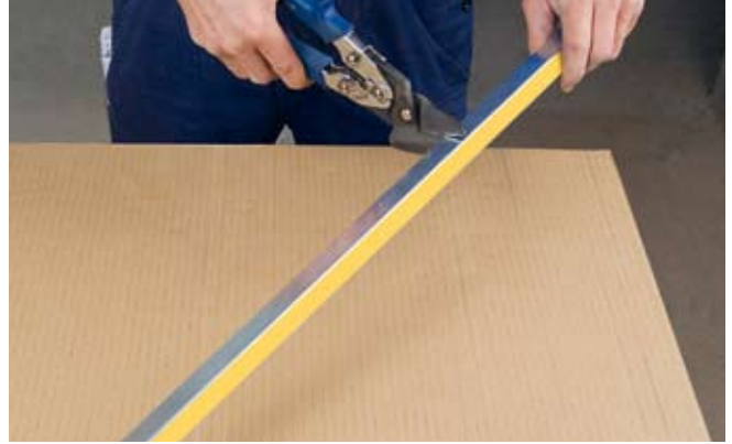
Und so geht's: Die Seitenschienen werden abgelängt...
