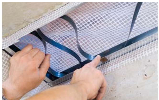
In den Rahmen wird das Stahlträgerband eingesetzt, das die Folie stützt
