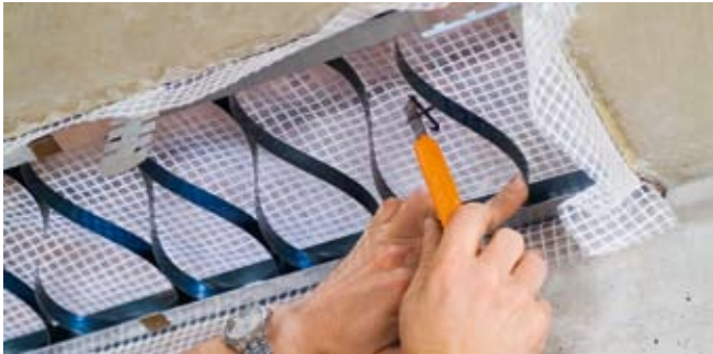
Dort, wo Rohre durchgeführt werden müssen, wird die Folie sternförmig eingeschnitten
