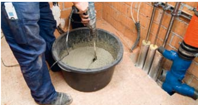
... die Vergussmasse angerührt und in den Deckendurchbruch auf die Spezialfolie geschüttet
