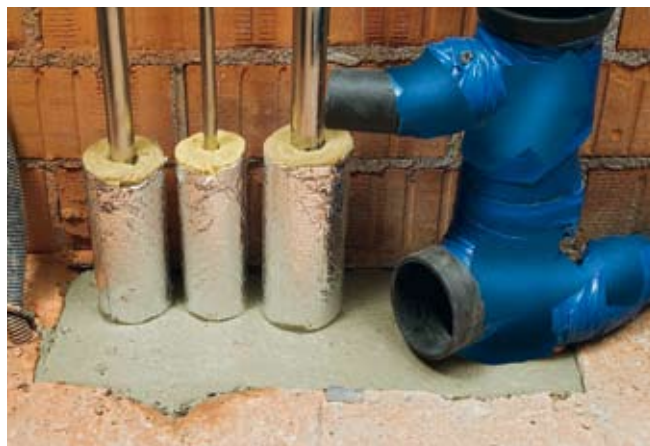
Sauber und dicht: Der Anlagenmechaniker verschließt die Rohrdurchführungen selbst
