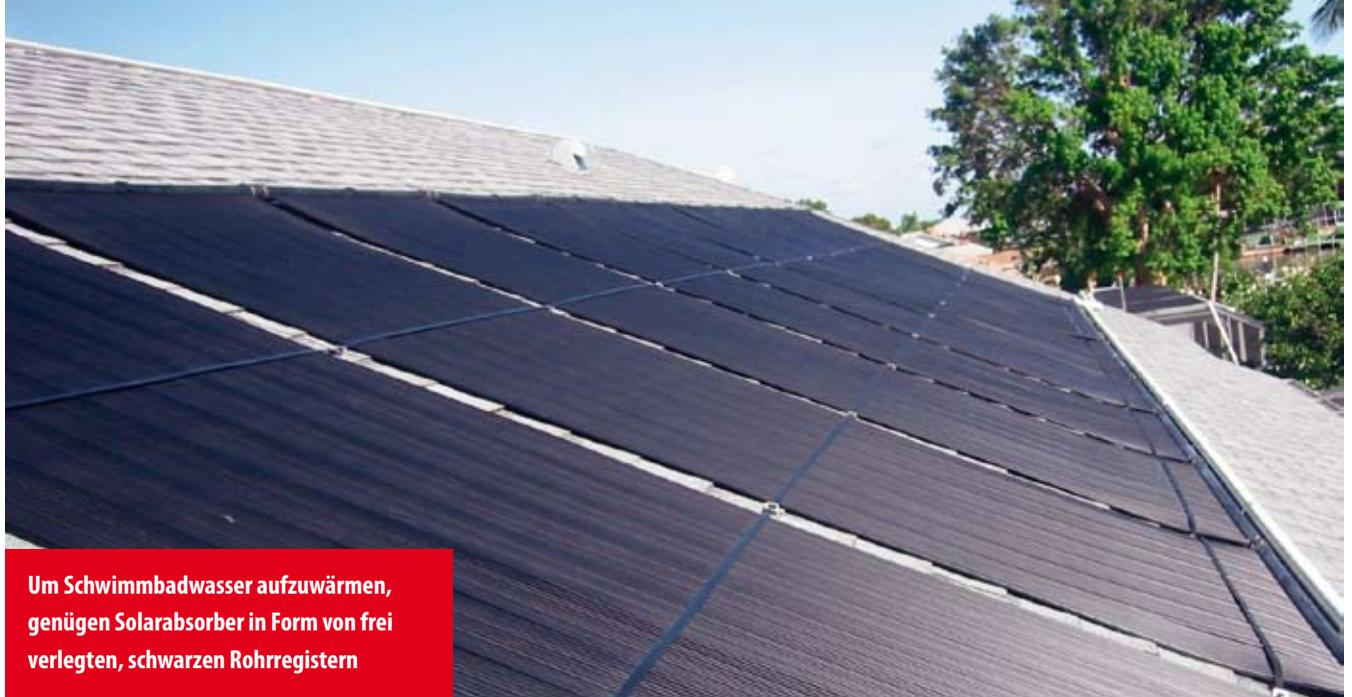
Um Schwimmbadwasser aufzuwärmen, genügen Solarabsorber in Form von frei verlegten, schwarzen Rohrregistern
