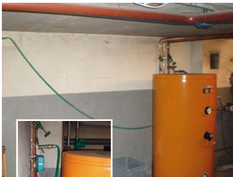
Gegengefälle, 30 m und mit plattem Querschnitt
