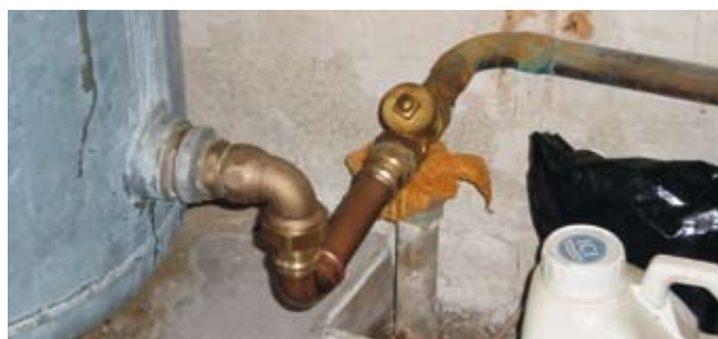
Aua! Ein Stahlbehälter wird über Kupferrohr befüllt...
