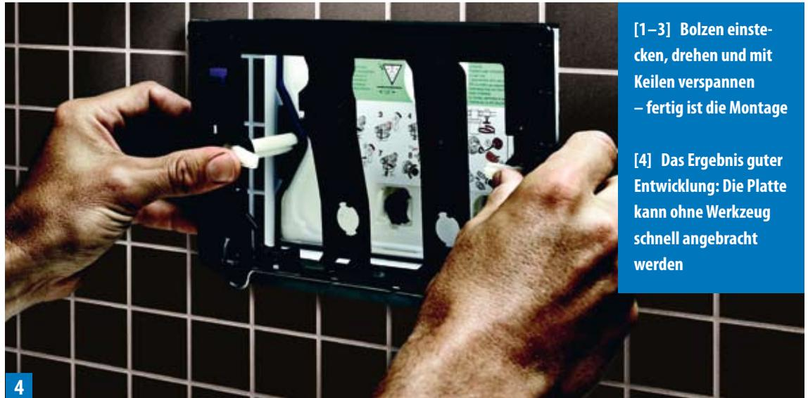
[1–3] Bolzen einstecken, drehen und mit Keilen verspannen – fertig ist die Montage
