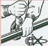
Kupferrohr rechtwinklig ablängen, dazu einen Rohrschneider benutzen.
