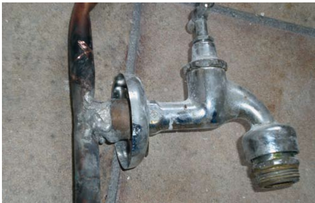
Nur für Profis: Ausgehalster Abzweig am CU-Rohr, weich gelötet
