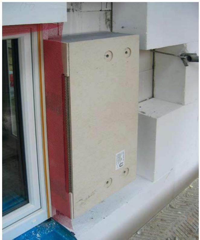
**Der Aufbau einer Wand entscheidet über den U-Wert und somit darüber, wie gut oder schlecht diese vor Wärmeverlusten schützt**
