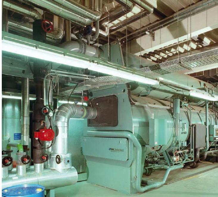
So sieht eine Absorptionskältemaschine in der Praxis aus
