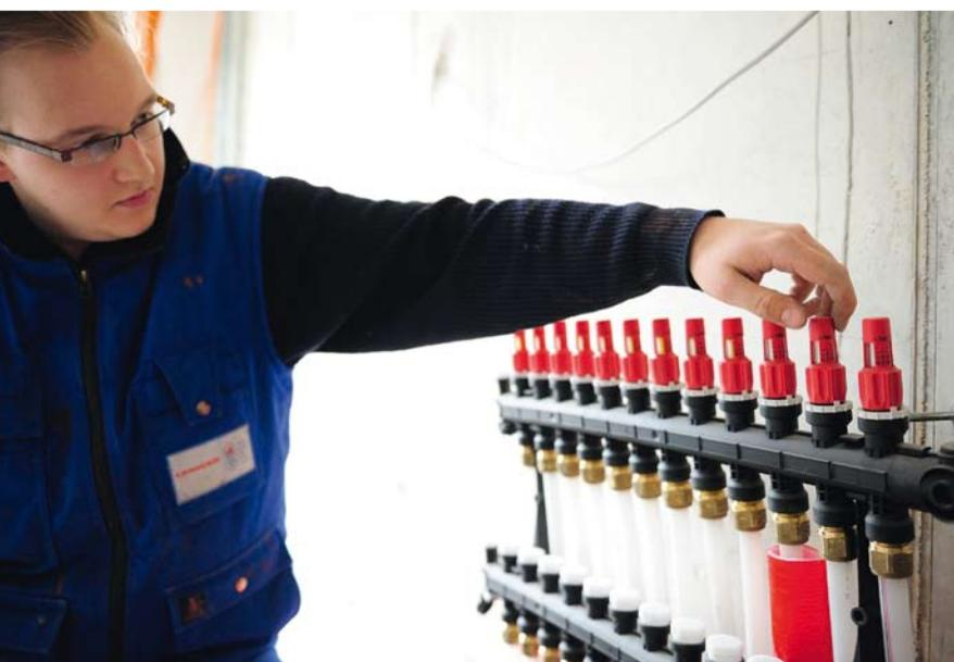
**Voraussetzung für den einwandfreien Betrieb des Systems ist ein hydraulischer Abgleich**
