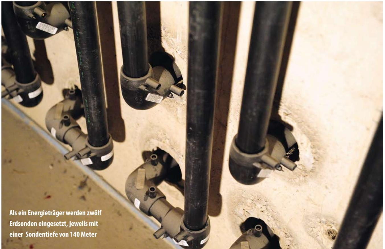
Als ein Energieträger werden zwölf Erdsonden eingesetzt, jeweils mit einer Sondentiefe von 140 Meter
