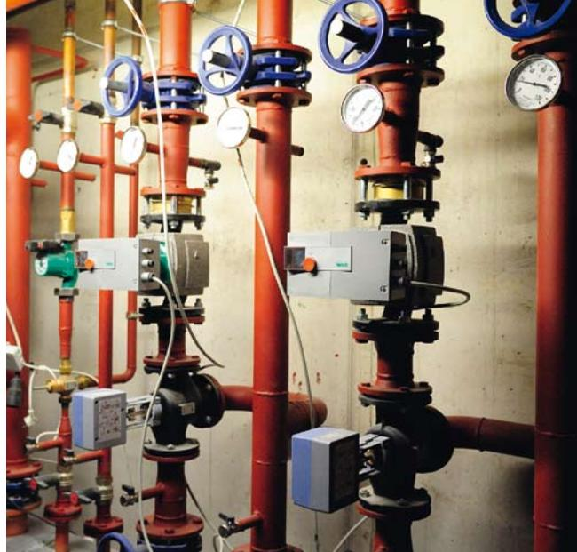
**In der Heizzentrale wird die Energieregulierung für die Heizung und Kühlung des Systems vorgenommen**
