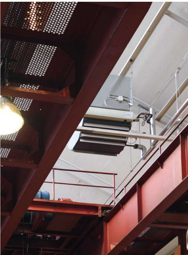
Bei hoch montierten Lufterhitzern weisen die Ausblaslamellen nach unten, um die warme Luft bis in den Aufenthaltsbereich zu lenken
