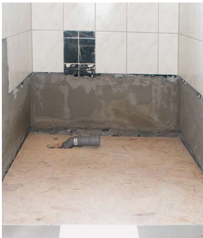
Der Estrichleger hat den Bereich, in dem die Dusche entstehen soll, ausgespart – nun kann es losgehen
