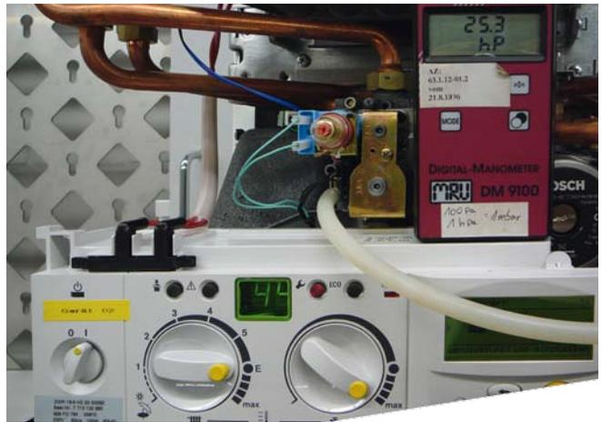
Den Schlauch auf den Anschlussdruck-Mess-Stutzen aufstecken und dann exakt den Anschlussdruck bestimmen
