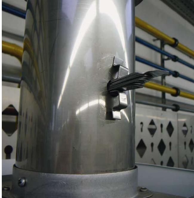
**Der Abgasfächer im Abgasrohr erzeugt einen Stau und zeigt, ob die Überwachung – AS oder BS – sicher funktioniert**
