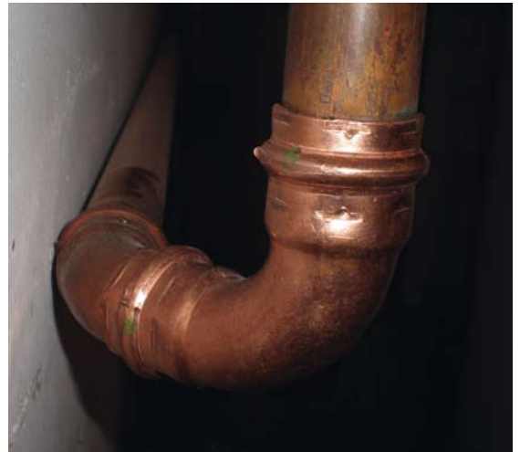
Hier das Bild aus dem März-Heft: Es ist wohl doch ein Wasserfitting
