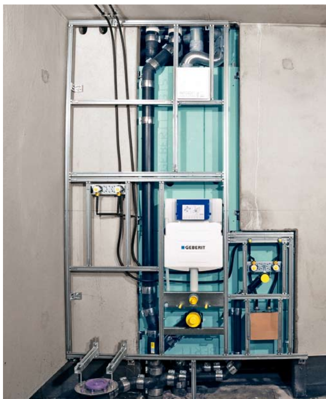
Die Vorwandinstallation wird im Bereich von Dusche und WC raumhoch, im Waschtischbereich teilhoch ausgeführt
