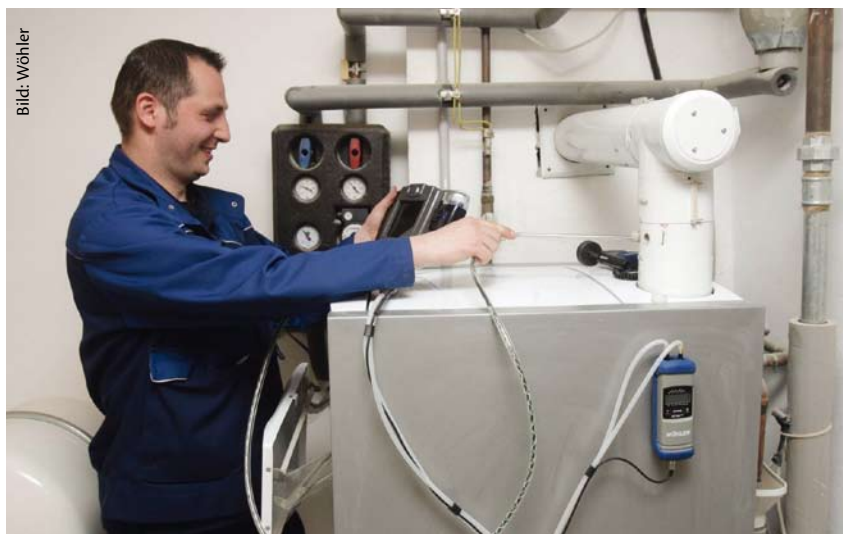
Kombi-Geräte unterstützen bei Bedarf die Messungen und liefern die Auswertung des Heizungs-Checks
