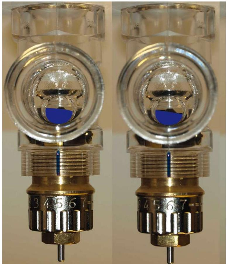
Einstellwerte von 5 bis N, dargestellt an einem Modell. Blau gefärbt der Widerstand...
