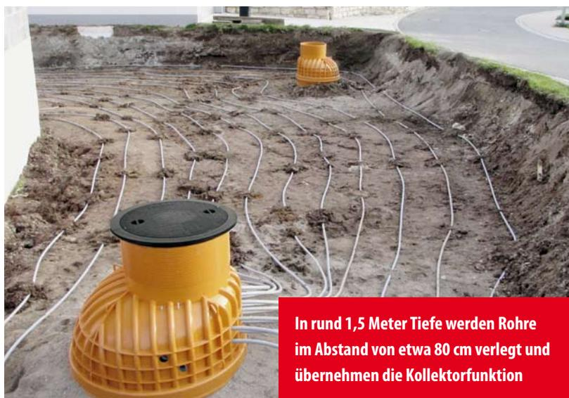
Die Jahresarbeitszahl moderner Sole/Wasser-Wärmepumpen in einem entsprechend angepassten Wohnhaus liegt bei 4,0. Und jetzt nochmals der Vergleich mit der Luft/Wasser-Wärmepumpe. Mit sehr viel weniger Aufwand attestiert man diesem Wärmepumpentyp unter guten Einsatzbedingungen eine Leistungszahl von um die 3,5.
