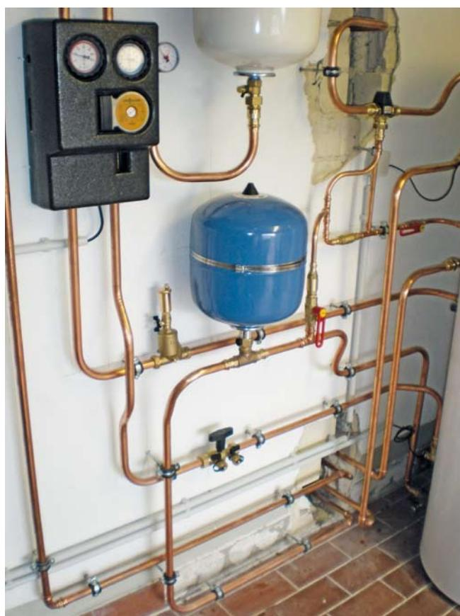
Besonders bei Neuanlagen häufig zu finden: Das durchströmte Membran-Ausdehnungsgefäß im Kaltwasseranschluss
