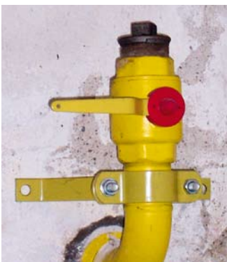
Vierkant- anstatt Sicherheitsstopfen; von Manipulationsschutz keine Spur
