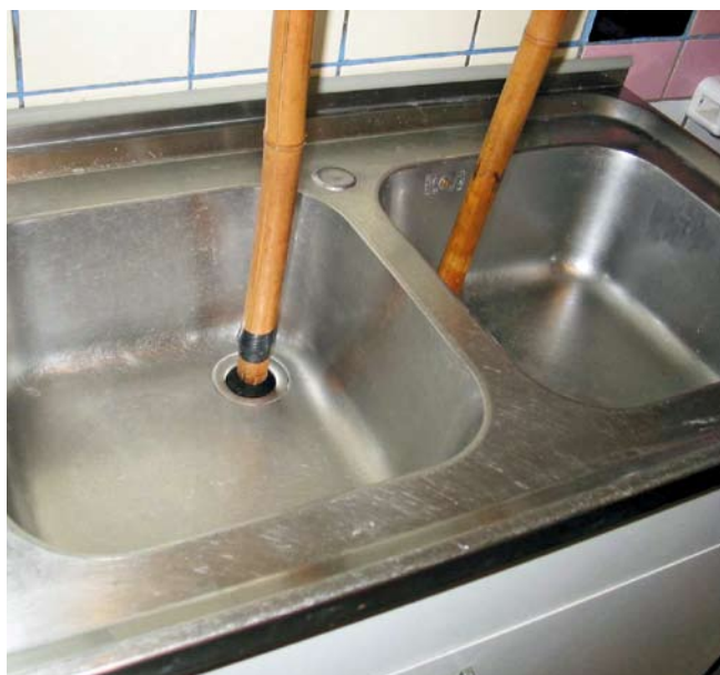
Vierkant- anstatt Sicherheitsstopfen; von Manipulationsschutz keine Spur
