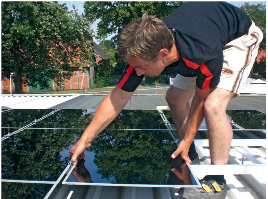
[8] Die Montage der Photonensammler wird in der Regel durch Fachbetriebe ausgeführt
