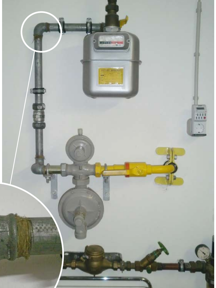
Wer so etwas baut, der hat das Prinzip eines Whitworth-Rohrgewindes nicht begriffen
