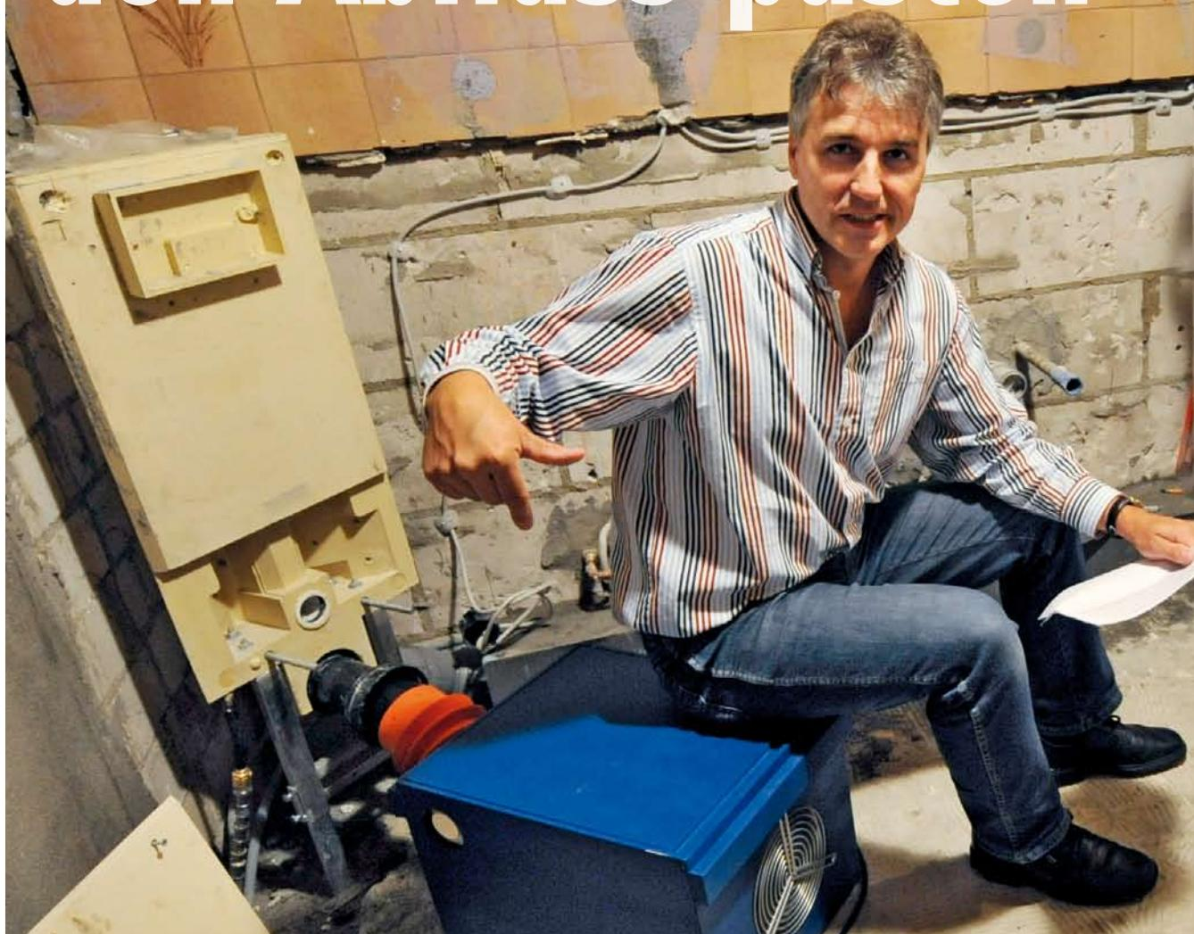
Wenn im Bad des Kunden alte Kacheln und Fliesen abgeschlagen werden, entstehen jede Menge Staub und Dreck. Schmutz, der durch alle Ritzen kriecht und sich in der Wohnung breit macht. Dem wirkt der Saugolator entgegen. Er erzeugt im Bad einen Unterdruck, indem er Luft absaugt und über den WC-Anschluss in den Abfluss drückt. Auf
