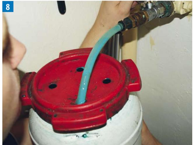
**8** An jedem Anschluss der Steigleitung wird Dispersion entnommen, um die Entlüftung der Leitung sicherzustellen
