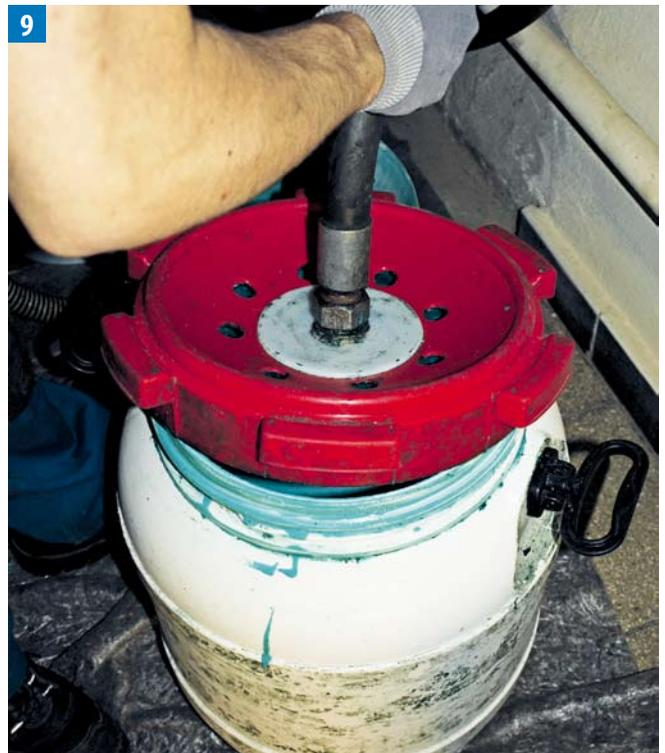
**9** Nach Ablauf der Standzeit wird der Füllschlauch von der Pumpe gelöst und am Entleerungseimer angeschlossen
