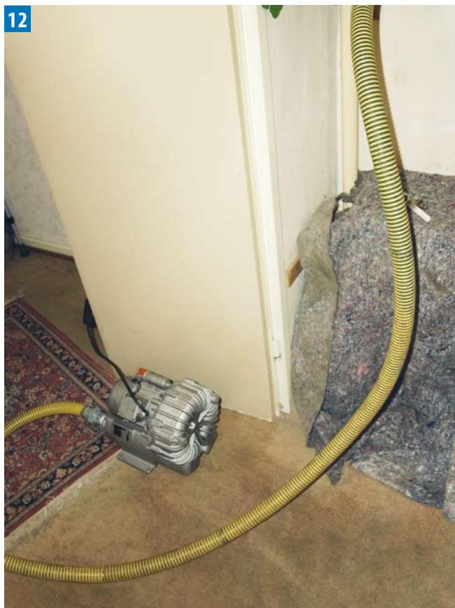
**12** Die von der überschüssigen Dispersion befreite Leitung wird mittels Luftgebläse getrocknet
