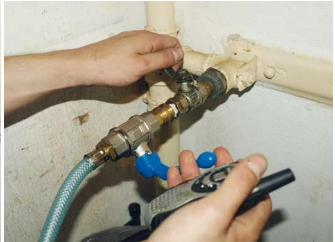
**Die vollständige Entfernung des Mittels besorgen die Molche, die von oben nach unten durch die Leitung gedrückt werden**
