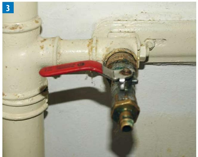
... und Kugelhähne für den Abdichtungsprozess eingebaut
