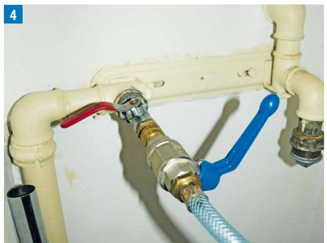
Die Steigleitung wird mit Stickstoff für rund fünf Minuten unter einen Druck von 3 bar gesetzt – Schwachstellensuche
