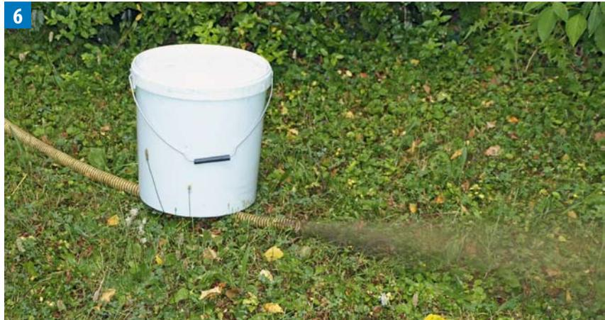
**6** Mit Druckschüben werden Verunreinigungen aus der abzudichtenden Leitung gepustet
