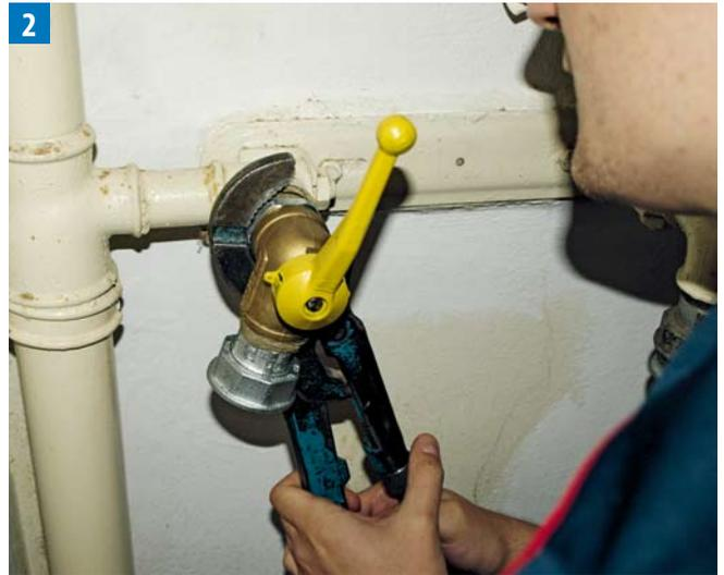
Die Gaszähler und Zähleranschluss-Armaturen in den Wohnungen werden demontiert...
