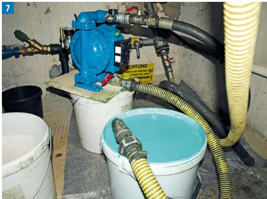
**7** Die Abdichtungsdispersion wird mittels Membranpumpe in die Steigleitung gedrückt
