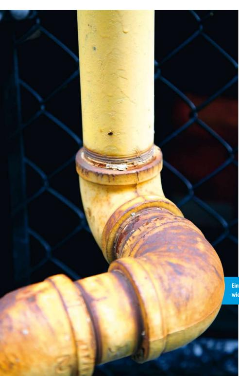
Gasleitungen bestehen überwiegend aus Metallrohren. Damit sie pflichtgemäß lange Jahre ihren Dienst tun können, ist fast immer ein Außen-Korrosionsschutz nötig. Und der muss exakt an die Umgebung angepasst sein.
