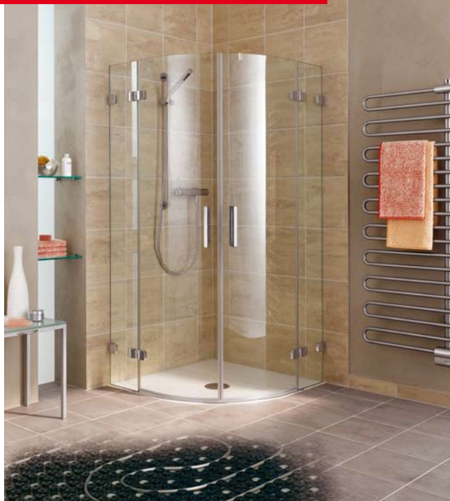
Für ein Badezimmer ist ein Kompromiss oft eine gute Lösung, die FBH-Schnecke (bifilar) und der HK
