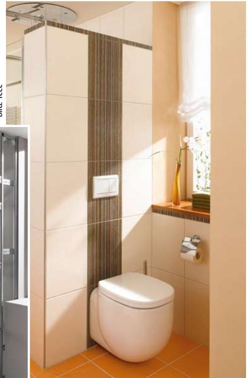
**Vorwandssysteme ermöglichen den Aufbau von Raumteilern; die Installation kann so auch von den Wänden weg realisiert werden**
