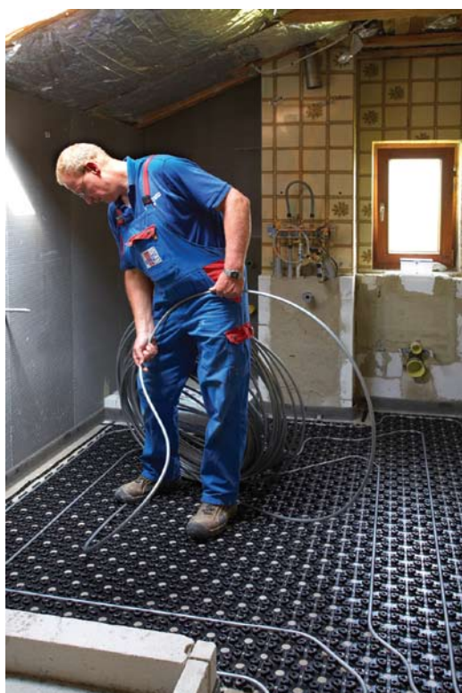
Das Fünf-Schicht-PE-Xc-Rohr wird in der Noppenfolie verlegt
