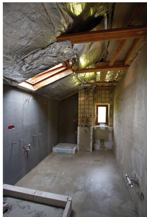
Der Innausbau des Bades wurde demontiert – Fliesen, Holzdecke, Armaturen, Heizkörper und Badewanne
