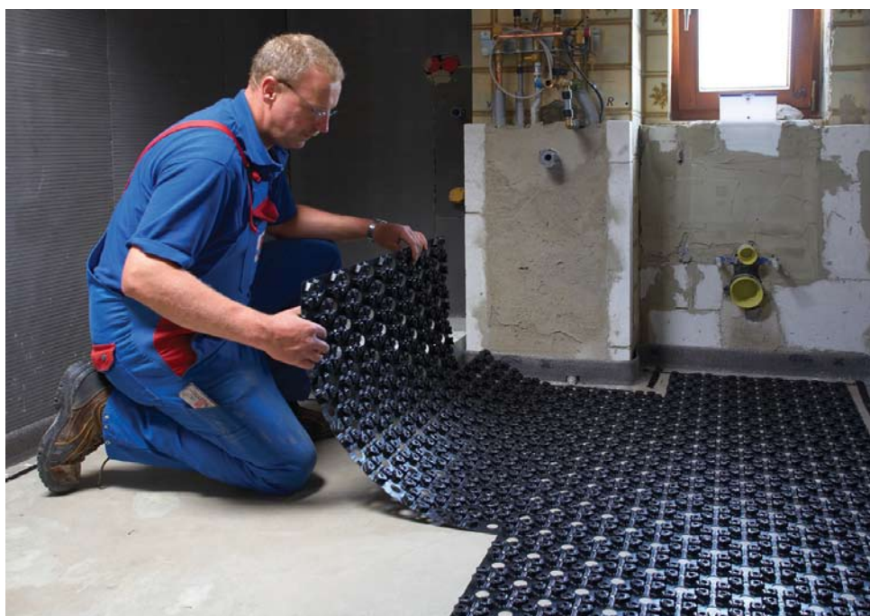
Die selbstklebende Noppenfolie kann direkt auf verschiedene Untergründe aufgebracht werden
