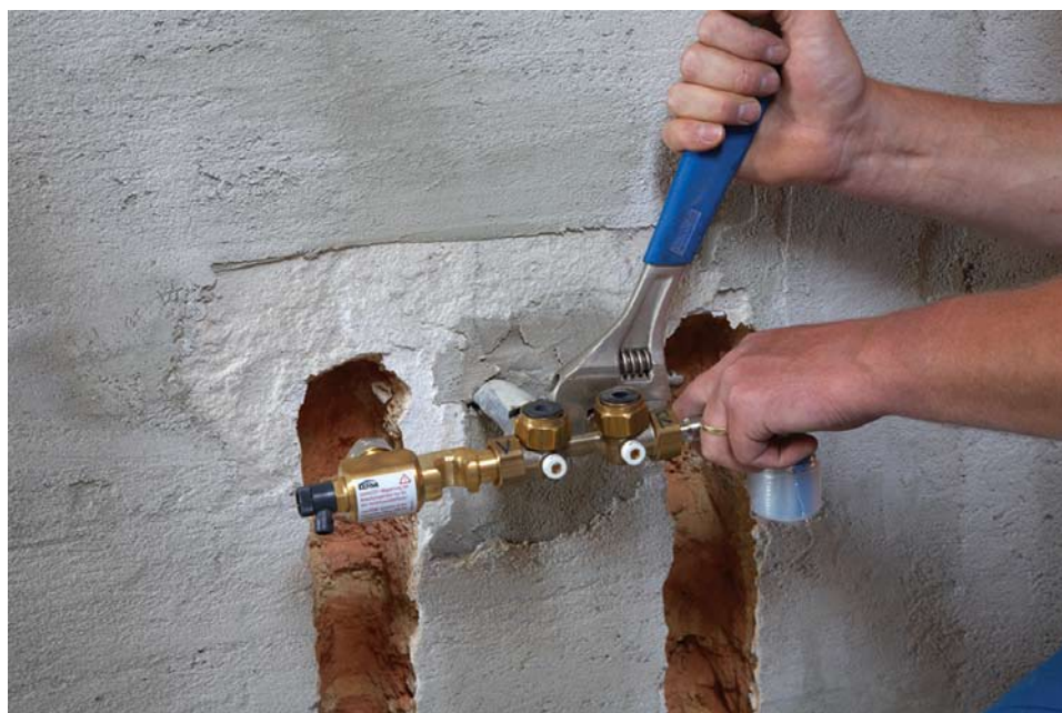
Die Xlink-Vormontageeinheit – prima geeignet für exakte Montage und Dichtprüfung der Rohranschlüsse
