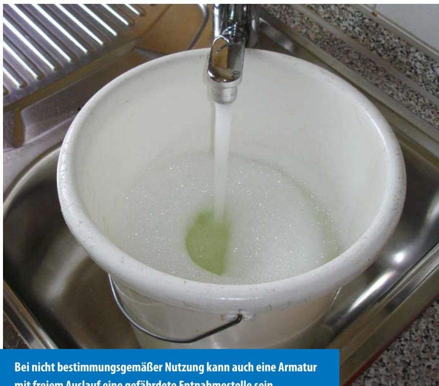
Bei nicht bestimmungsgemäßer Nutzung kann auch eine Armatur mit freiem Auslauf eine gefährdete Entnahmestelle sein
