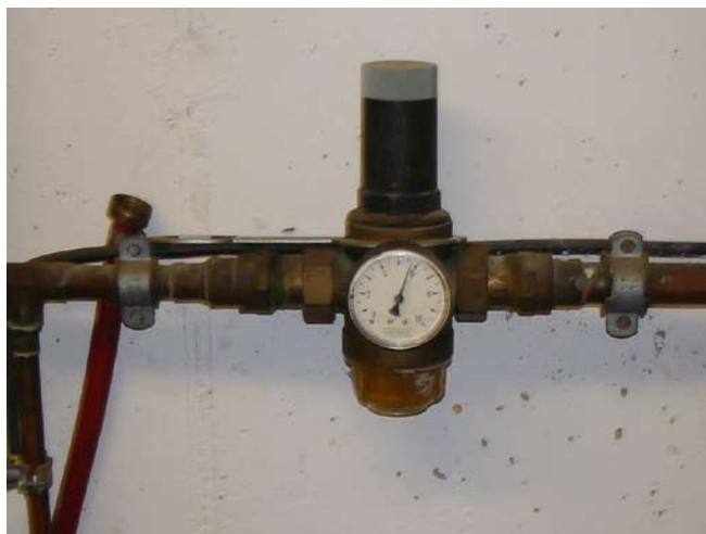
**Bei Druckminderern geht es bei der Wartung vor allem um die Reinigung und die Kontrolle der Regelfunktion**
