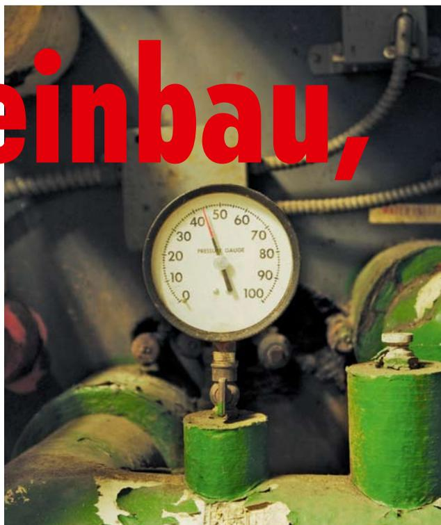
Der Anlagendruck; in Heizungsanlagen ist er eine wichtige Größe
