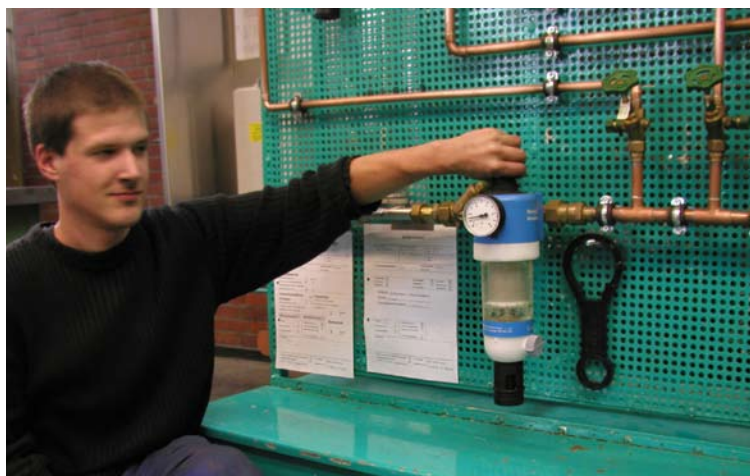
Die Montagewände ermöglichen Wissensvermittlung ganz dicht an der Praxis
