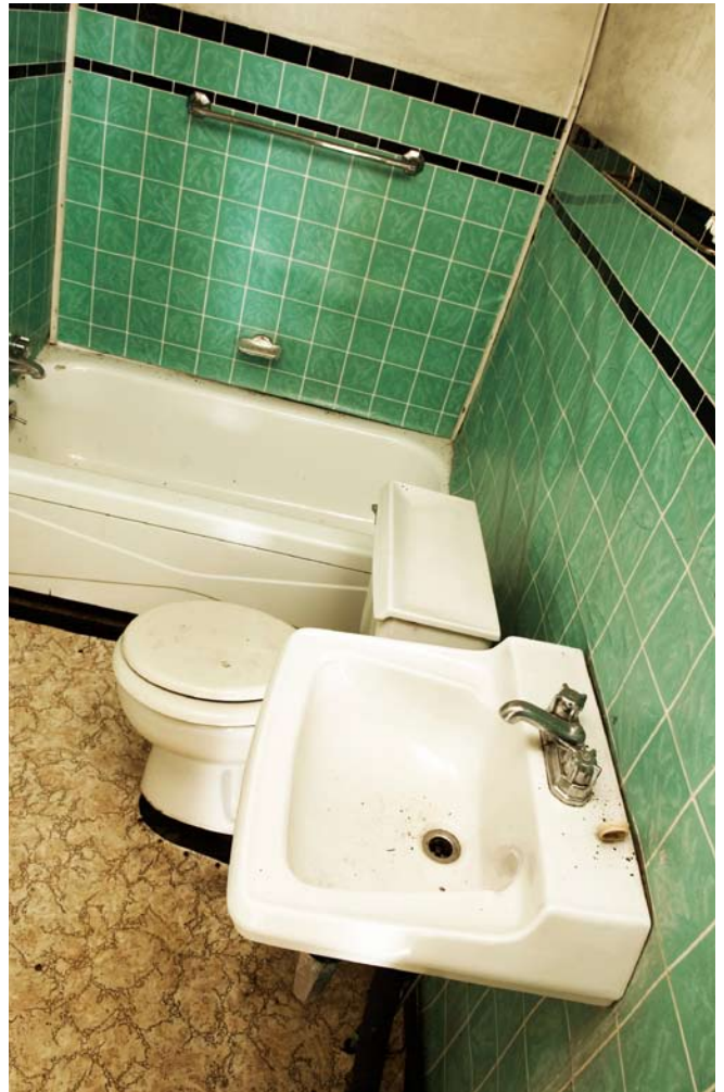
Anfang der 50er-Jahre fand das Bad den Weg in die Wohnung und die Wasserinstallationen nahmen an Umfang zu
