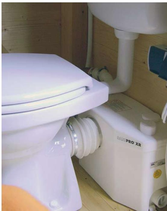
Die SFA Sanibroy Hebeanlage Sanipro XR entsorgt das Abwasser aus WC und Waschtisch
