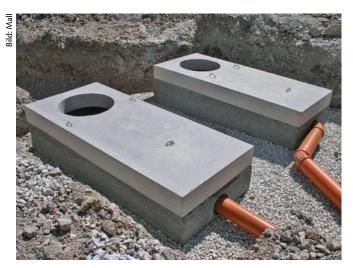
Sickerkammern in dieser Form bestehen meistens aus Beton und sind auch zum nachträglichen Einbau in oberflächennahe Bodenschichten geeignet
