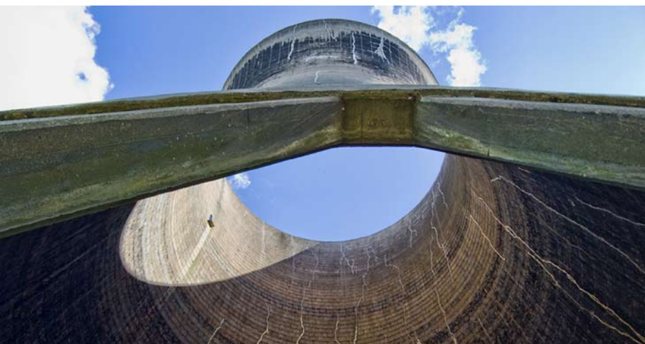
Hier strömt die Luft in den riesigen Kamin eines Naturzugkühlturms
