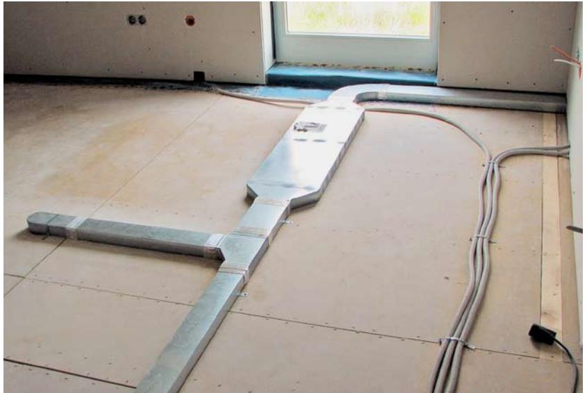
Flache Kanäle sind gefragt um diese im Fußboden verstecken zu können
