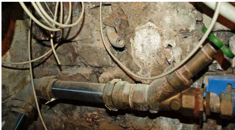
So soll es sein: Das alte Bleirohr ist von der Installation abgetrennt
