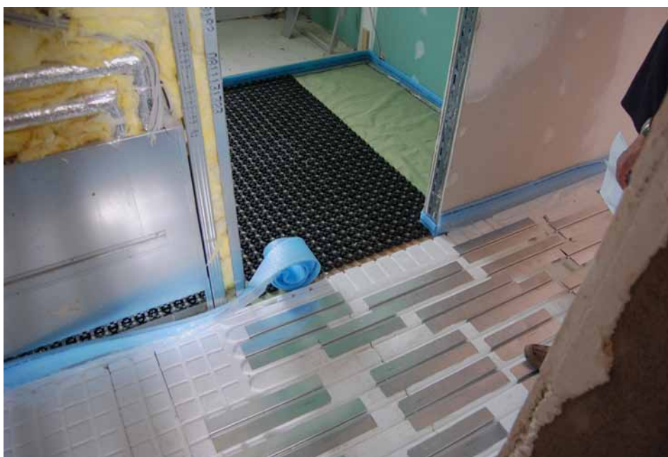
Zwei unterschiedliche Fußboden- heizungssysteme in einem Haus ermöglichen bedarfsgerechte Lösungen
