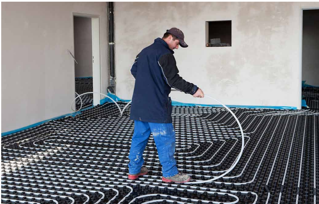
Bevor die Rohrlängen verlegt werden, ist die Dämmung dran
