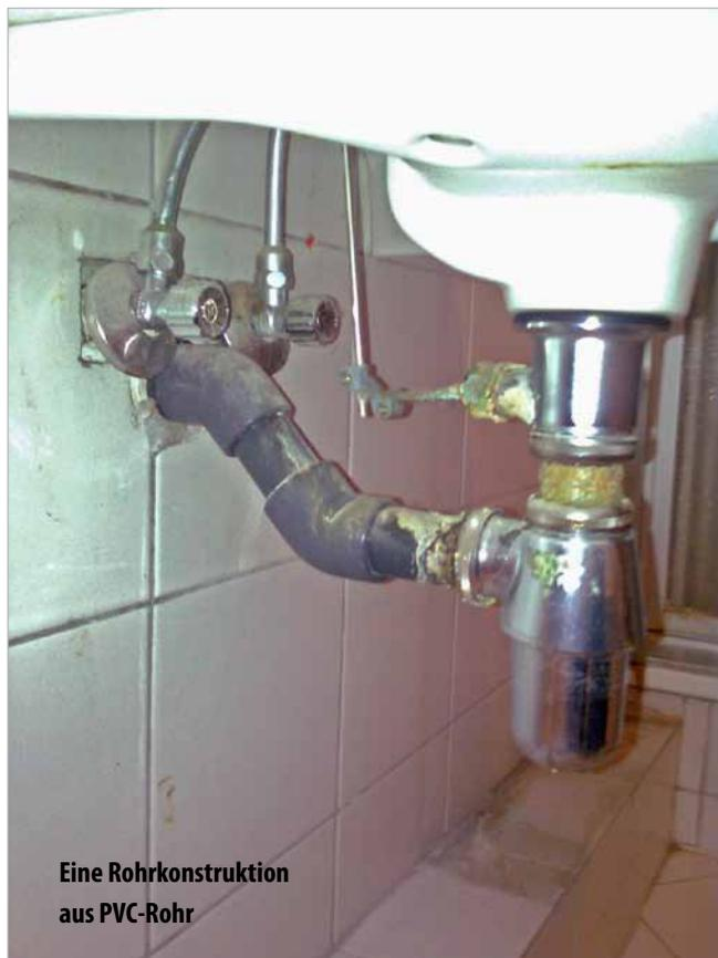
Eine Rohrkonstruktion aus PVC-Rohr
